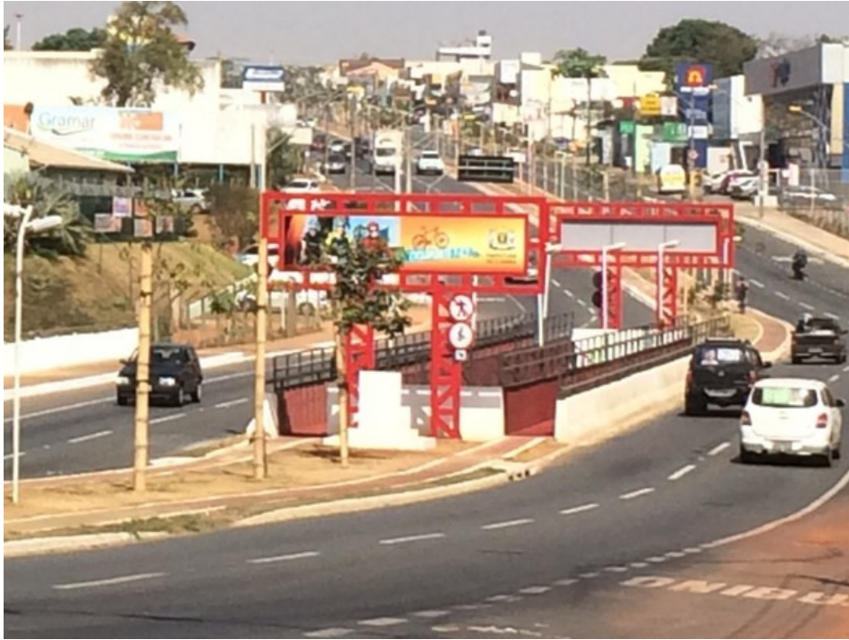
Ponte metálica sobre o Córrego Cascavel interligando a ciclovia no Corredor de ônibus T-63 – Goiânia/GO – foto extraída do site g1.globo.com , em 12 de agosto de 2016.
